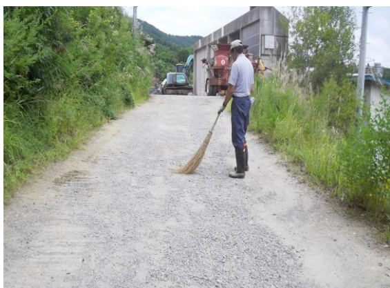
処分場内の清掃
